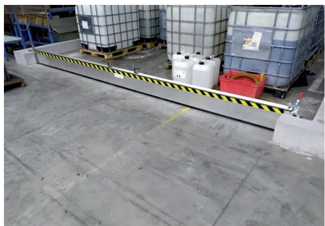
La barrière rigide est prévue pour une mise en place manuelle opérée par un ou plusieurs opérateur(s) selon la longueur de l'ouverture. Elle nécessite la pose de poteaux d'ancre permanent sur les bords droit et gauche de l'ouverture. Elle se compose de panneaux en aluminium d'une hauteur fixe de 250 mm munis de joint en EPDM. Selon le volume potentiel de liquide à confiner ou à bloquer, la barrière fera de 250 mm de hauteur jusqu'à 2000 mm.
